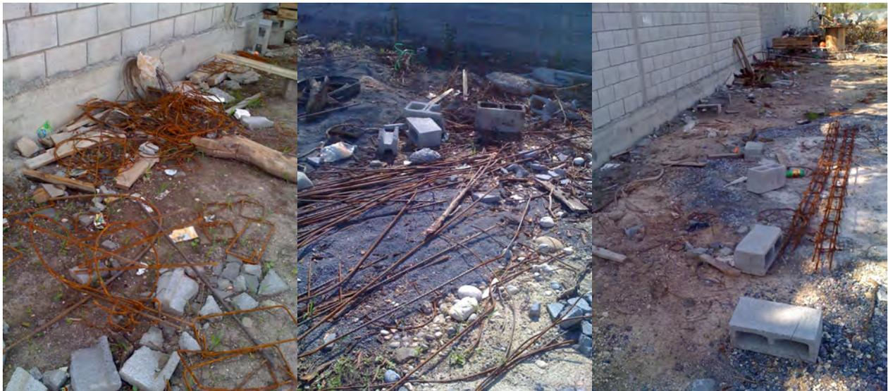
Figura 2.2 Fotos del desperdicio del acero
