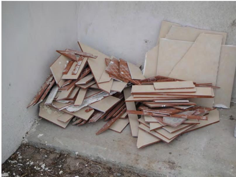
Figura 6.2 Foto donde se muestra desperdicio de piso en obra
