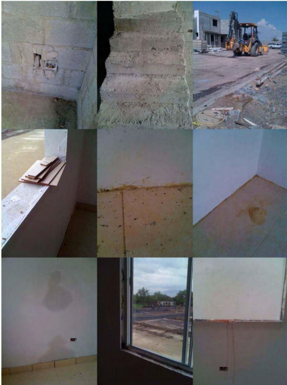
Figura 12.4 - 13.2 Estas fotografías muestran desperdicios de block,piso,yeso y mortero
