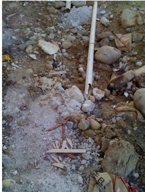
Figura 6.5 Foto donde se muestra desperdicio de la tubería de PVC en obra
