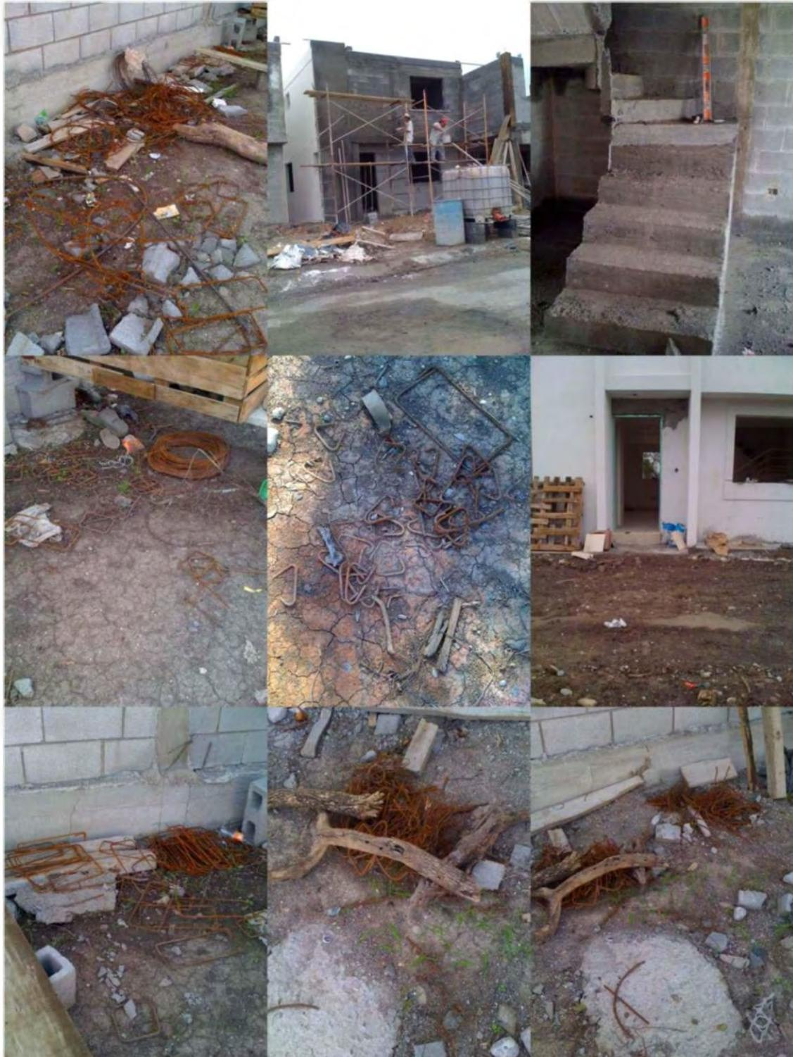
Figura 13.3 - 14.1 Estas fotografías muestran desperdicios de acero y mortero
