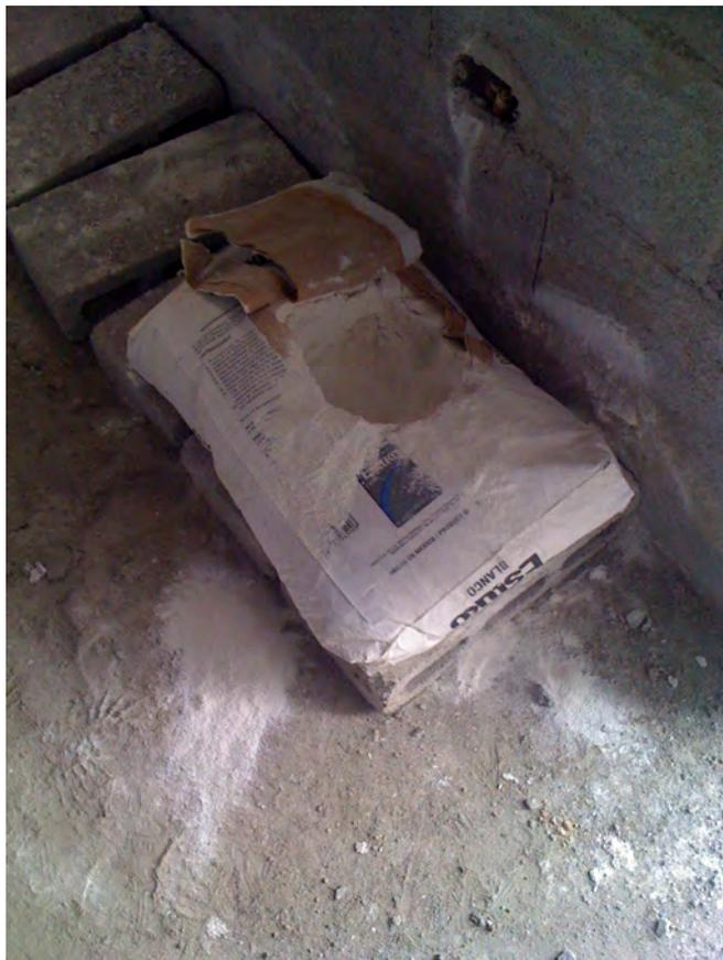
Figura 4.3 Foto donde se muestra desperdicio de estuko en obra
