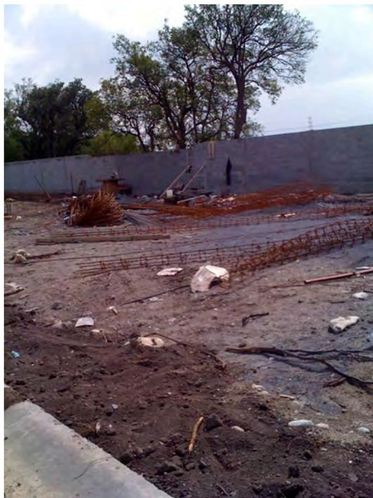
Figura 7.7 Foto donde se muestra desperdicio de acero en obra
