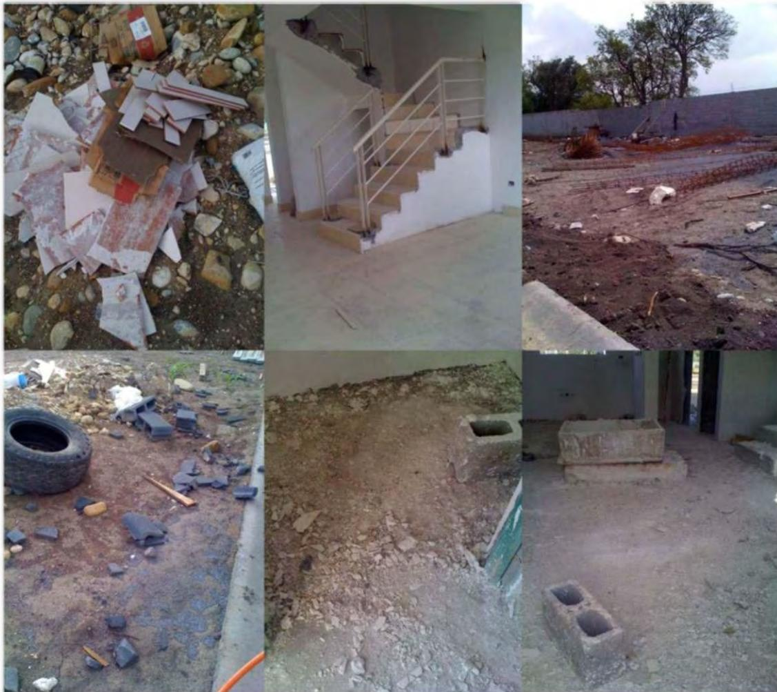
Figura 8.2 - 8.7 Estas fotografías muestran desperdicios de piso, acero, blocks y yeso
