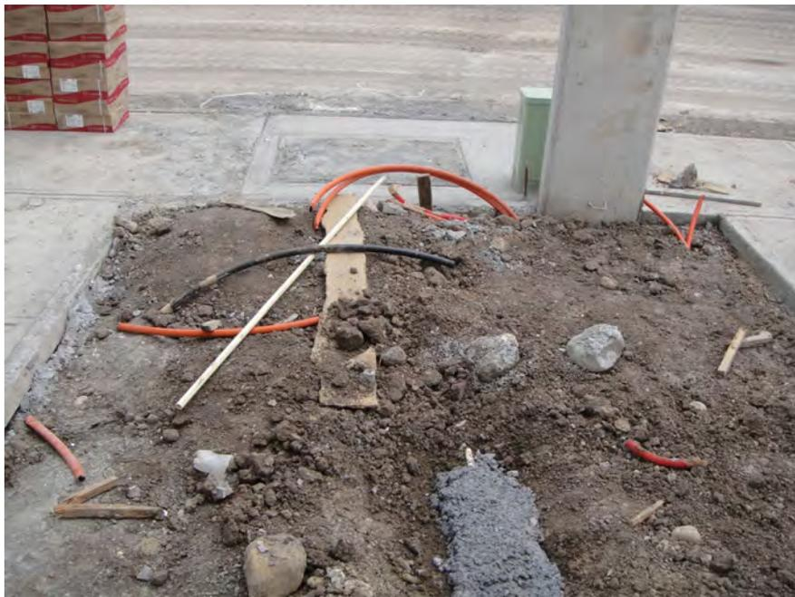
Figura 5.6 Foto donde se muestra desperdicio de concreto premezclado en obra
