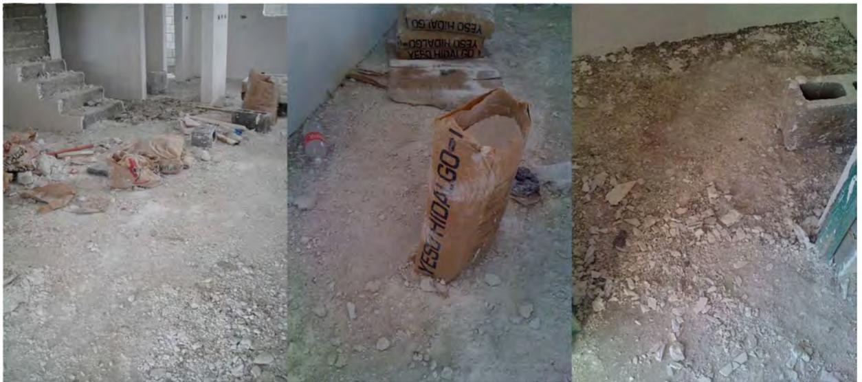
Figura 2.6 Fotos del desperdicio de la mezcla de yeso
