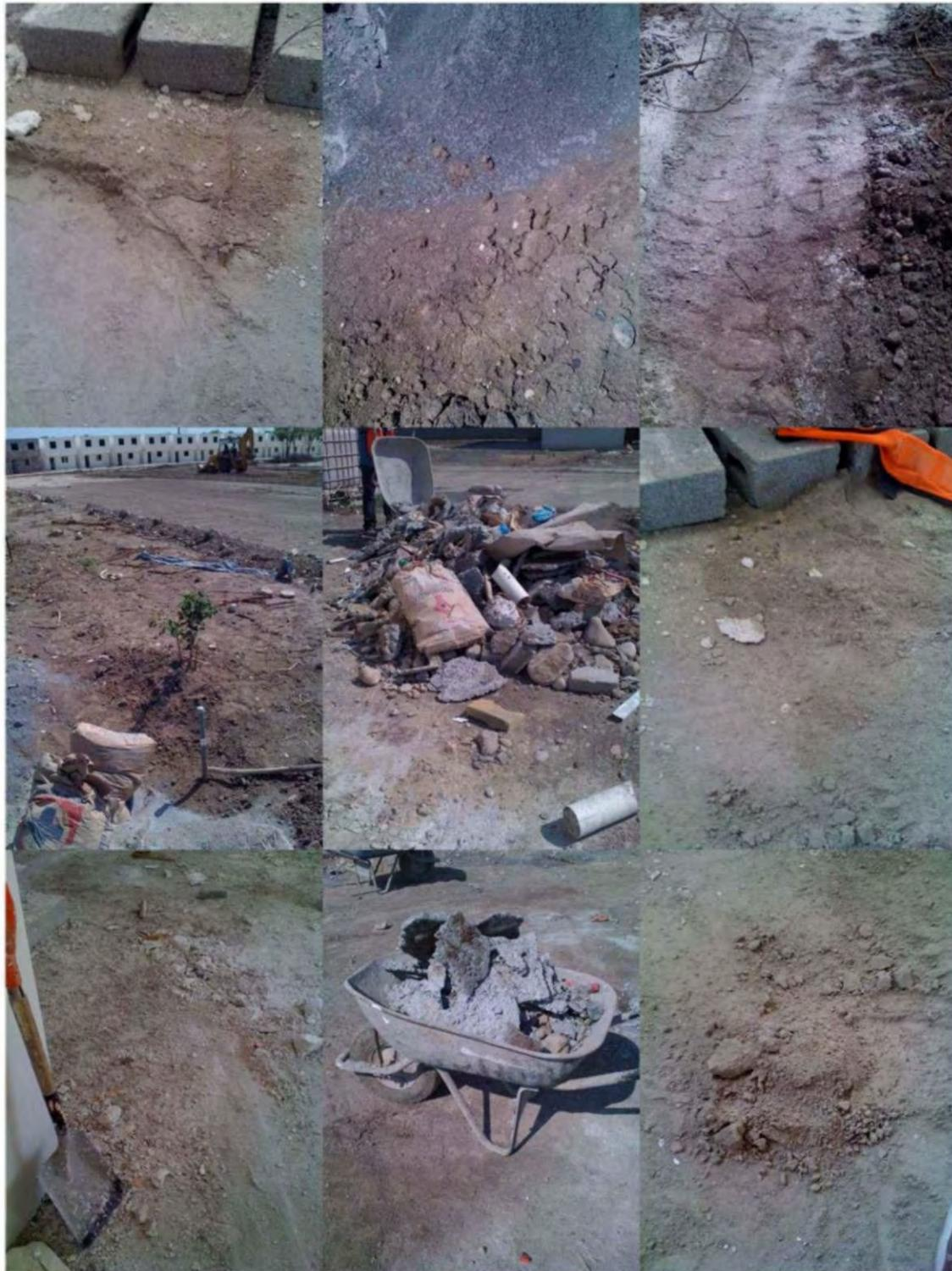
Figura 16 - 16.8 Estas fotografías muestran desperdicios de mortero y estuko
