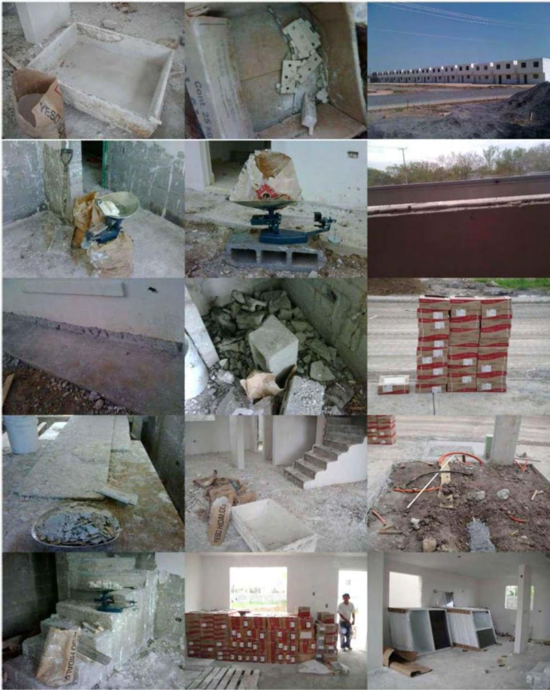
Figura 20.2 - 21.6 Estas fotografías muestran desperdicios de yeso, accesorios, estuko, block y piso
