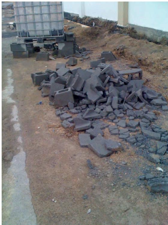
Figura 7.4 Foto donde se muestra desperdicio de blocks en obra
