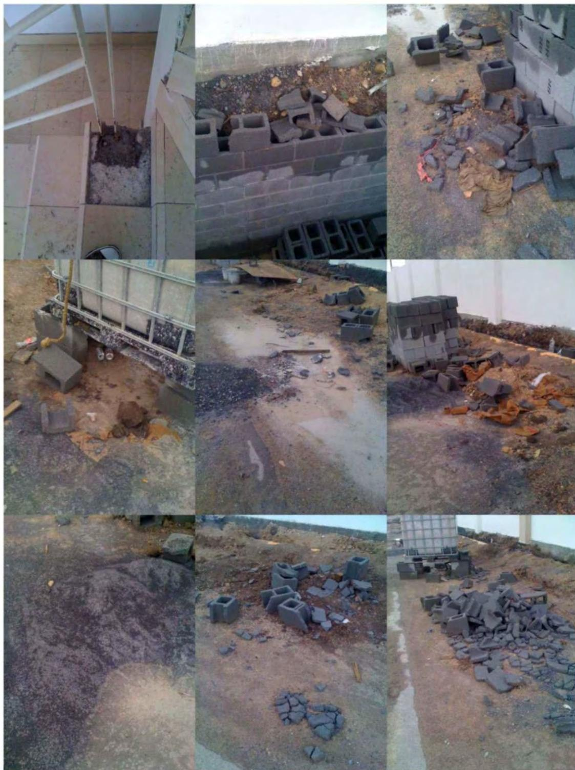
Figura 11.5 - 12.3 Estas fotografías muestran desperdicios de piso,block y mortero
