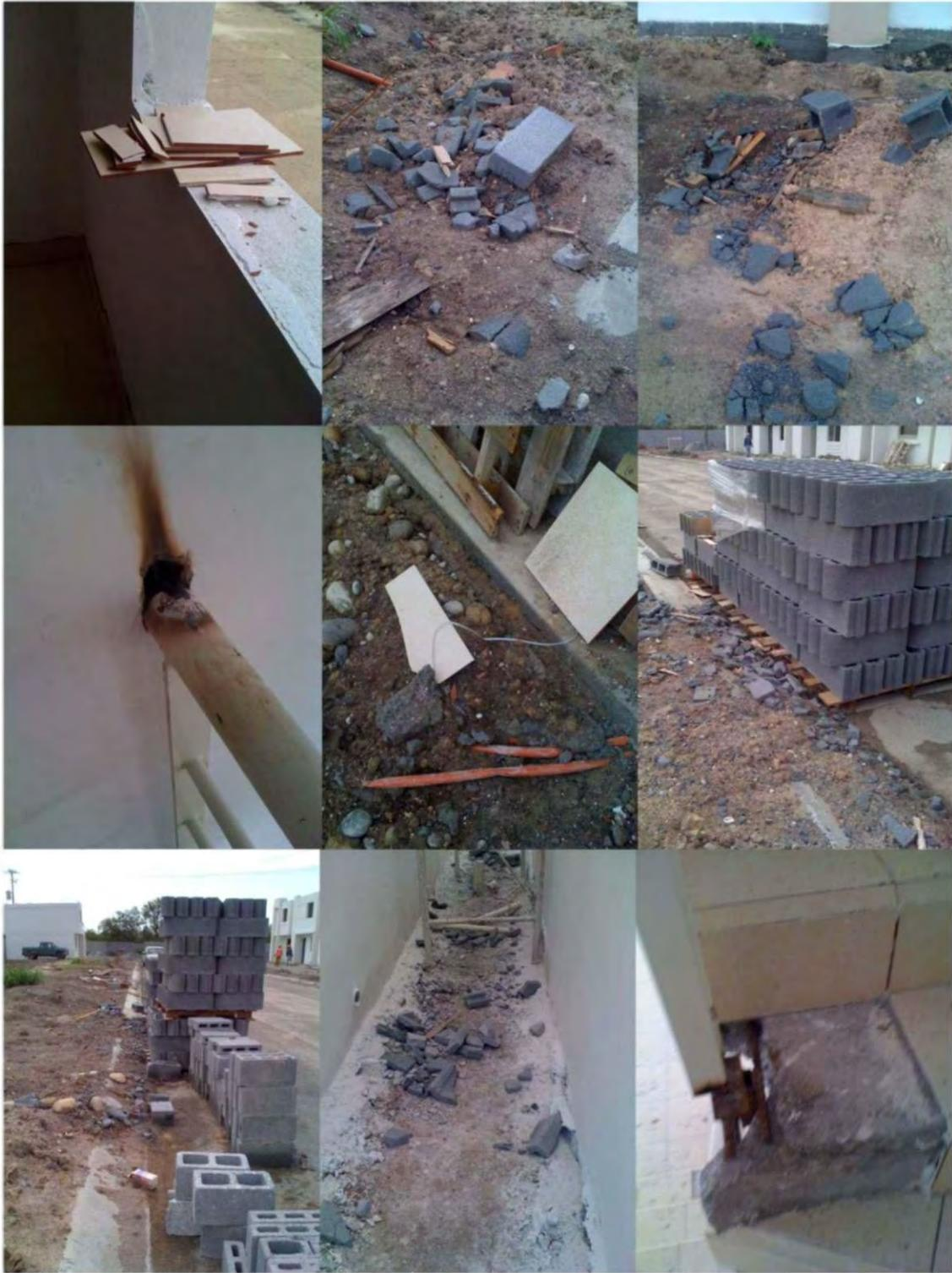
Figura 10.6 - 11.4 Estas fotografías muestran desperdicios de block, piso y tubería
