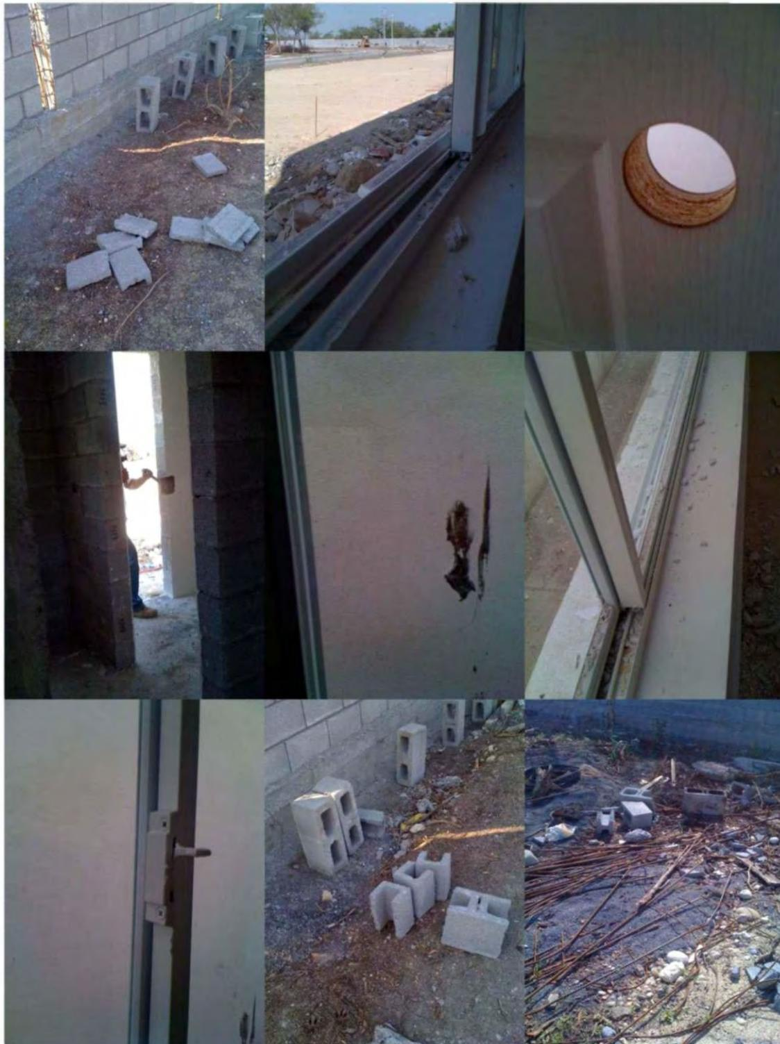
Figura 15.1 - 15.9 Estas fotografías muestran desperdicios de yeso,block,accesorios y acero
