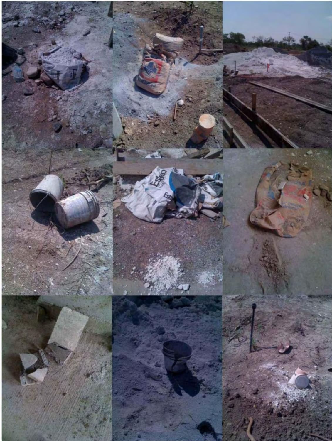
Figura 16.9 - 17.7 Estas fotografías muestran desperdicios de cemento y estuko
