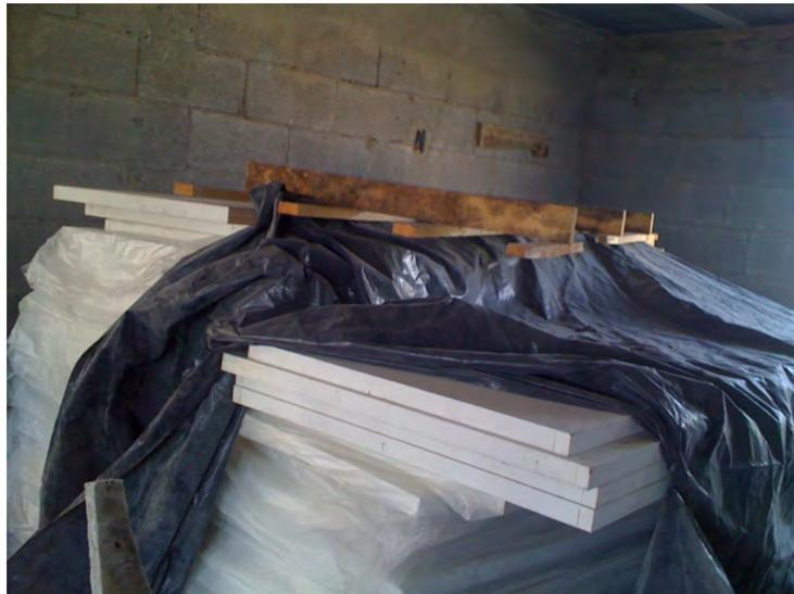
Figura 7.1 Foto donde se muestra desperdicio de puertas en obra
