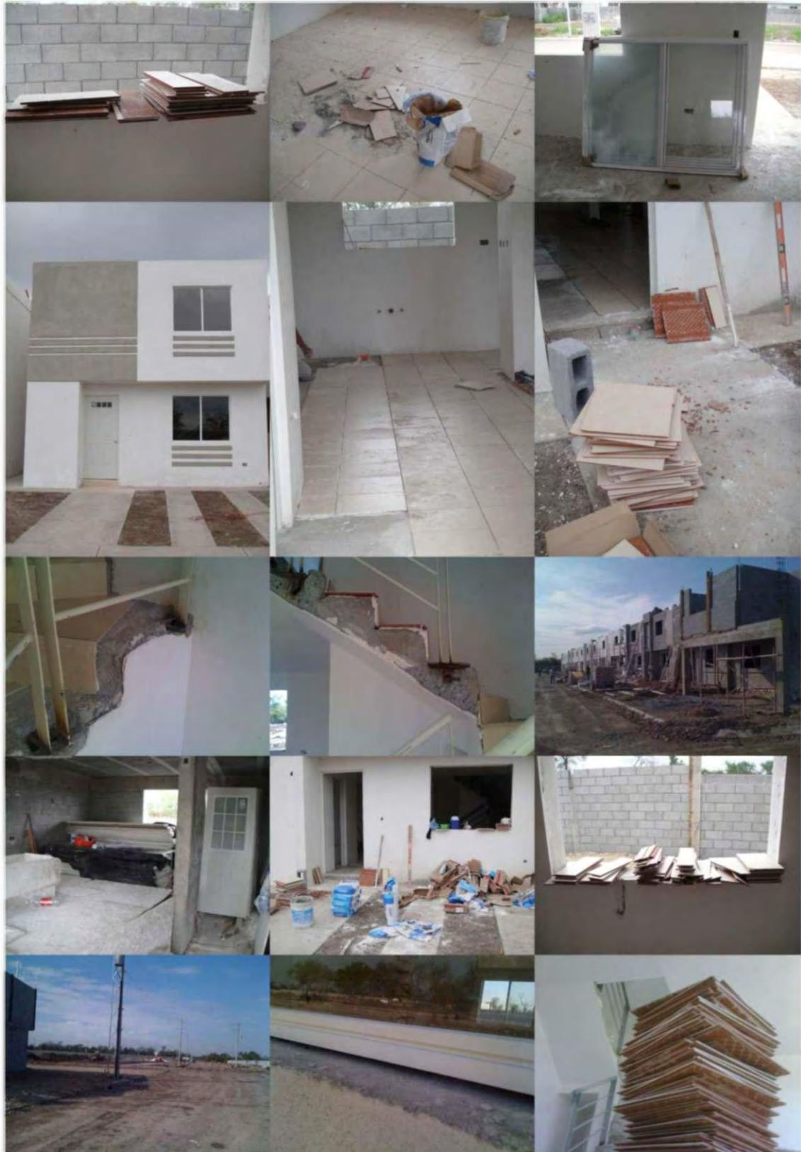
Figura 17.8 - 19.2 Estas fotografías muestran desperdicios de estuko,piso,mortero y accesorios
