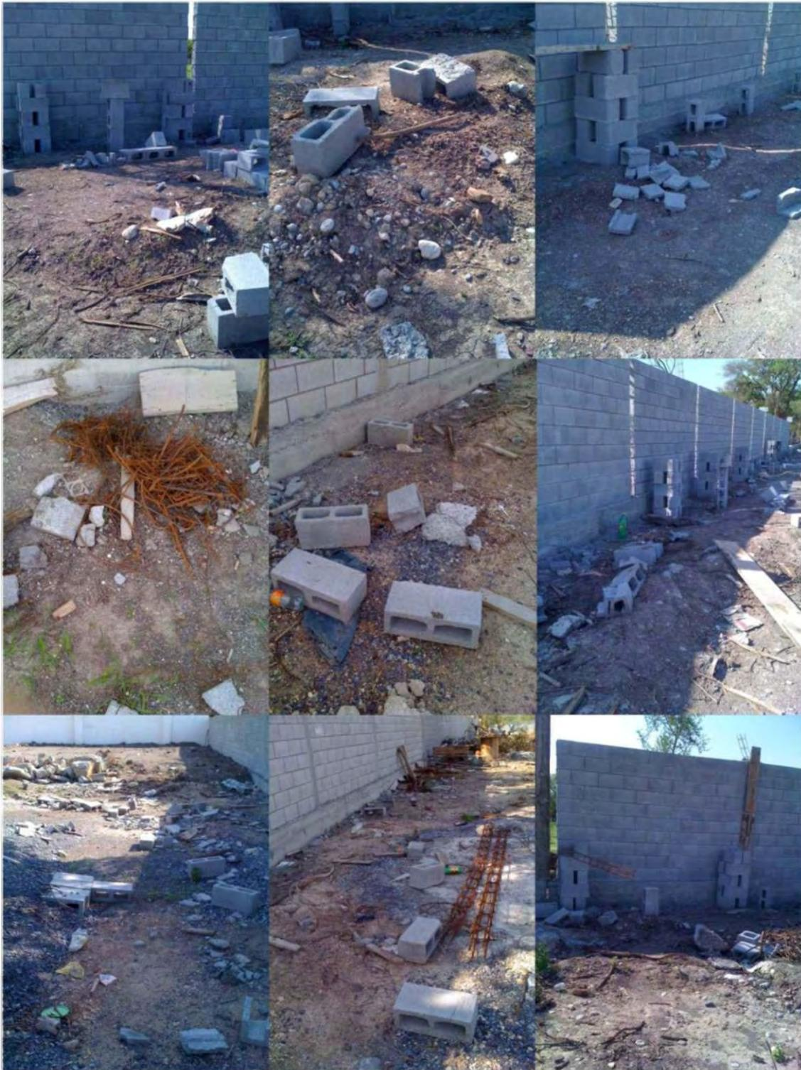
Figura 14.2 - 15 Estas fotografías muestran desperdicios de block y acero
